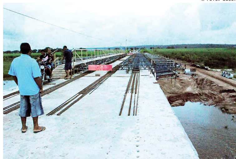
A Ponte da Batalha, entre Santa Rita e Espírito Santo, passa por reforma
