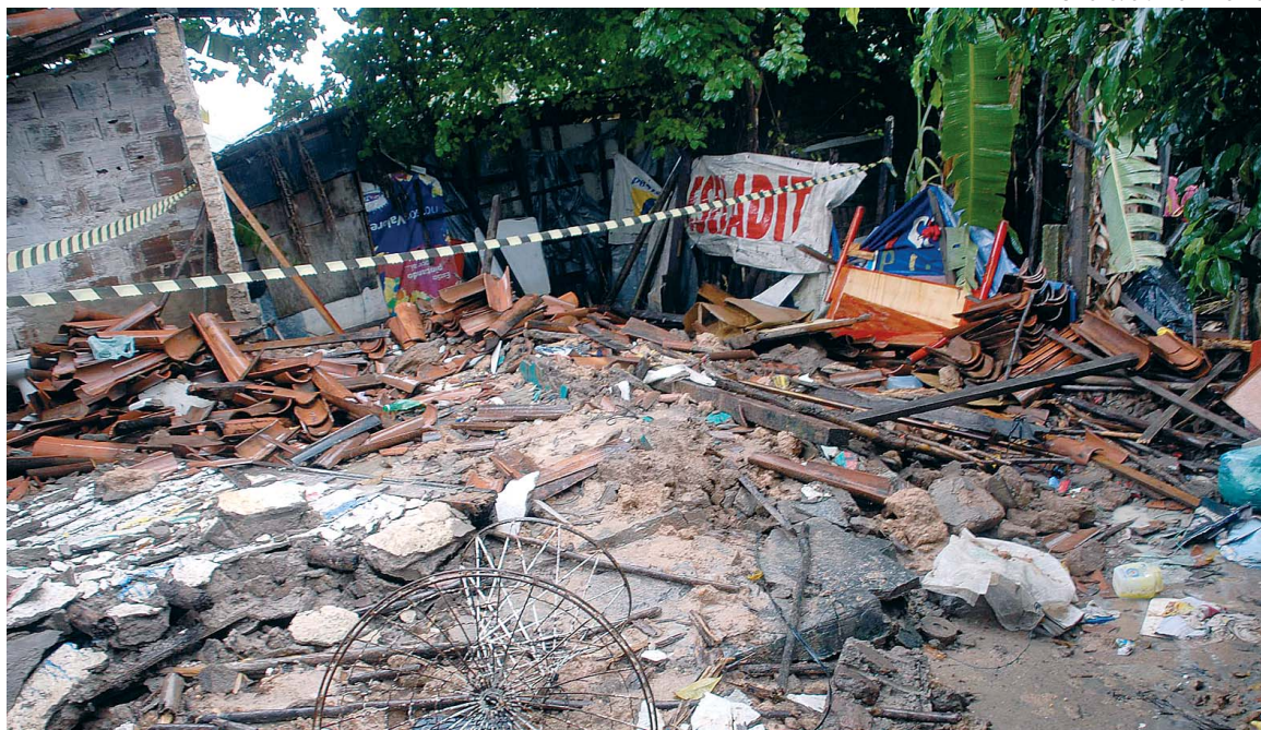
Casa demolida pelas chuvas foi interditada pela Defesa Civil estadual na comunidade Esperança, bairro Padre Zé
